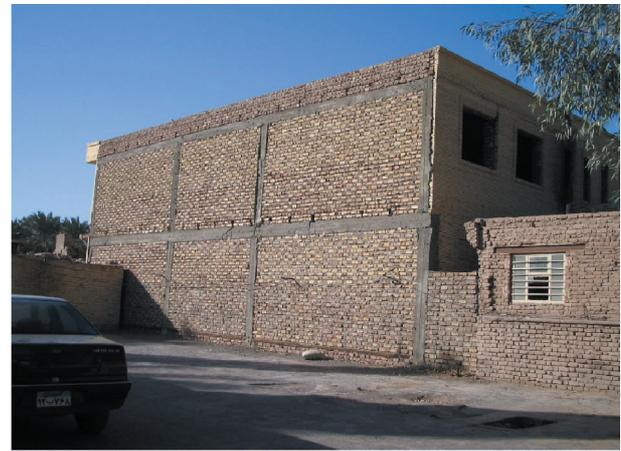
(d) Masonry with RC Frame (Vulnerability class D).
