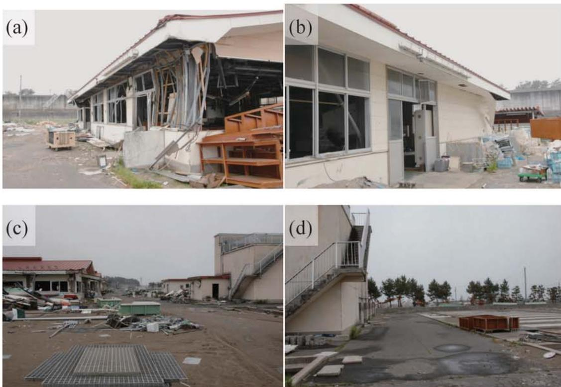
Fig. A14. (a)-(c) Damage at Taneichi Fishing Port. (d) Tsunami trace survey point at the step (I2).
