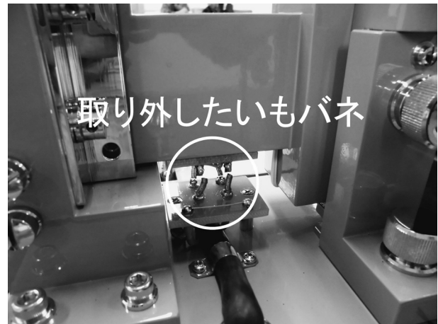
図 4. いもバネの取り外し
