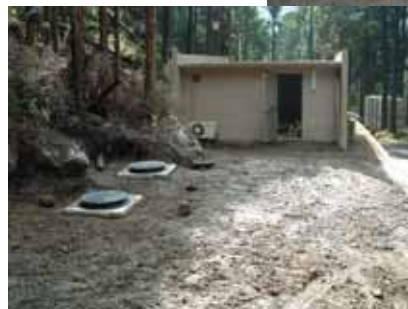
図8 地震研究所富士川観測所奥山観測室に掘削された観測井(深さ 10m x 2 本)
