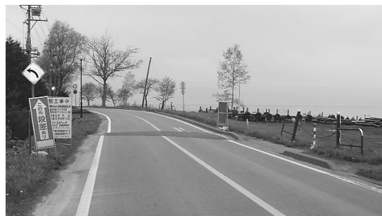
図4 有珠火山観測所へ向かう途中の道路上に現れた断層。金比羅山火口まで2kmほどの地点。
