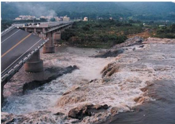
図1．地震断層は豊原市大甲溪に滝をつくり、橋を壊した（1999年9月23日撮影）。
