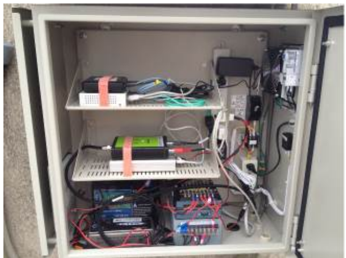
図4 機器収納キャビネットの取付状況 (左) 外観。(右) 内部の状況。上段にはルーター及びハブ、中段にはGPS受信機及びデータ収集用PC、下段には無停電電源装置が収納されている。
