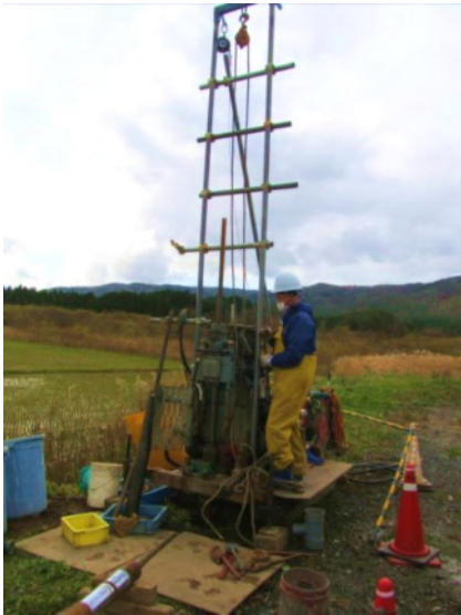
写真1 地点1での掘削風景
