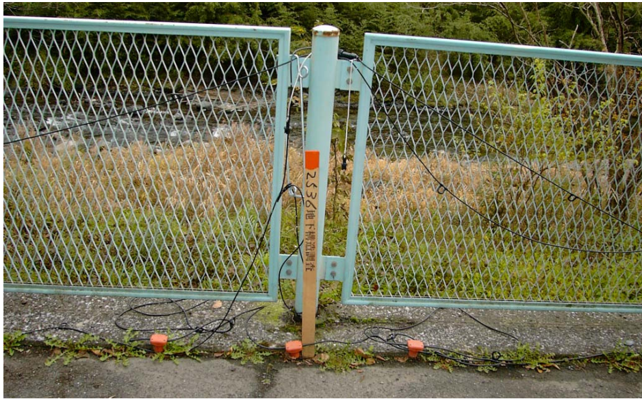
写真1 埼玉県名栗村下名栗地区県道 53 号青梅秩父線。 入間川護岸に設置された受振器 UM-2、受振番号 RP. 2536 地点。
