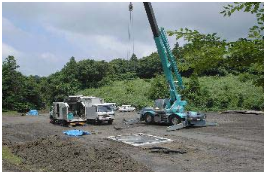
図 36 V S P 作業風景、左から検層車、観測車、およびクレーン車 バイブレータ震源は敷地外のため写っていない。
