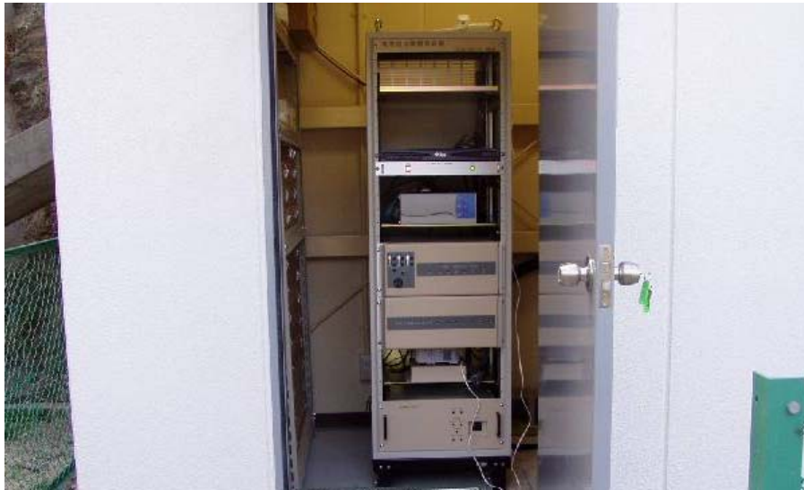
図 43 地上装置機器収納ラック
