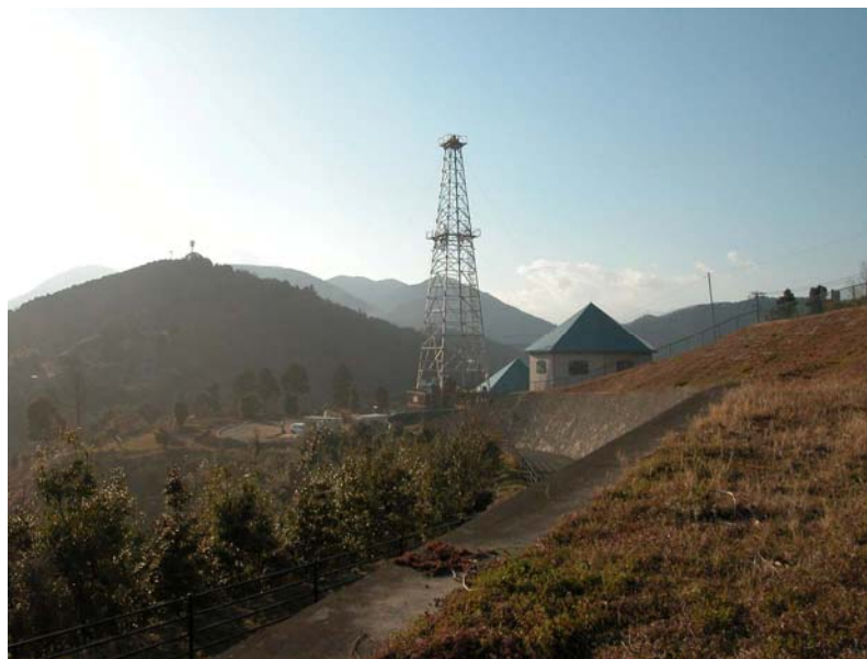
図14 掘削装置遠景（東方より望む）
