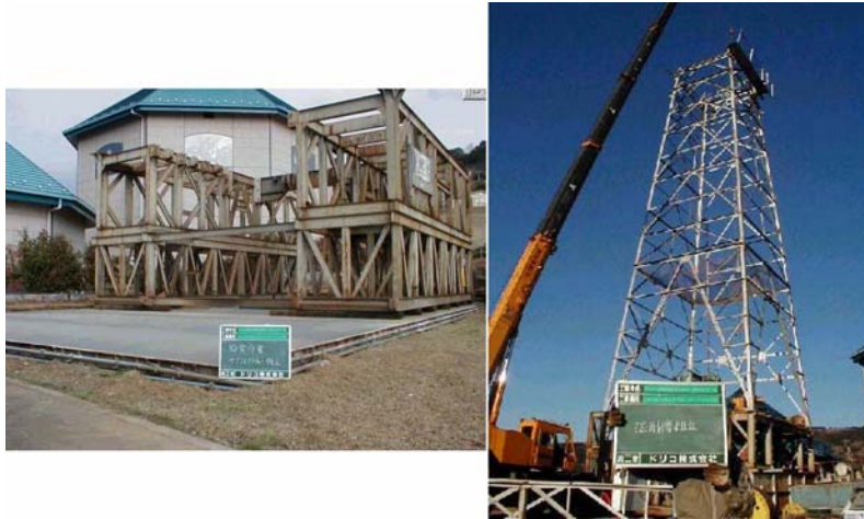
図13 槽設営風景（左図 サブストラクチャーの組み立て、右図 槽の組み立て）
