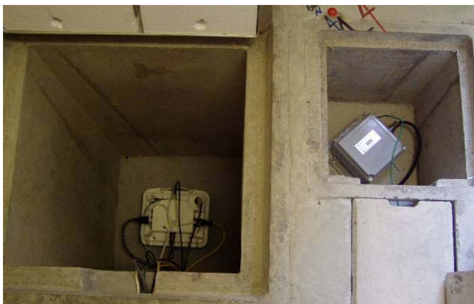
図42 観測施設内地下ピット
