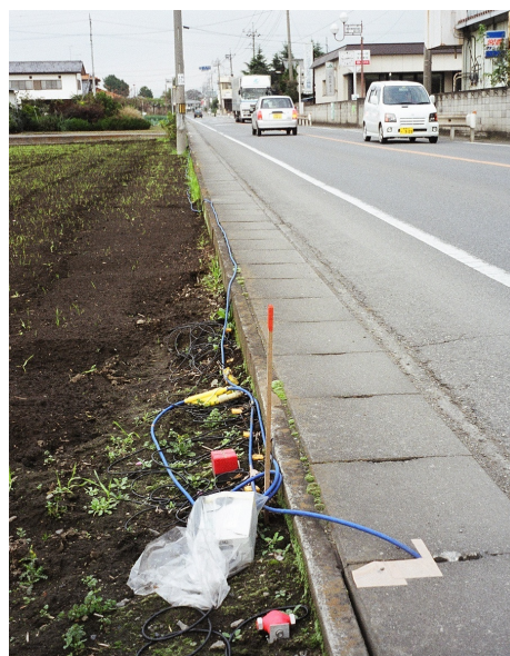
写真5 群馬県新田町大根地区県道 315 号線。（RP. 391）。S 波観測 LS8200 設置状況 (2)
