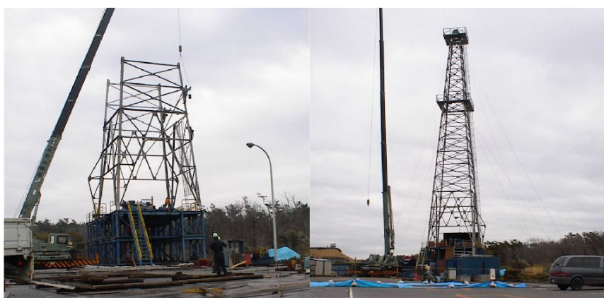
図7 櫓設営風景(左図:櫓の組み立て、右図:櫓の全景)
