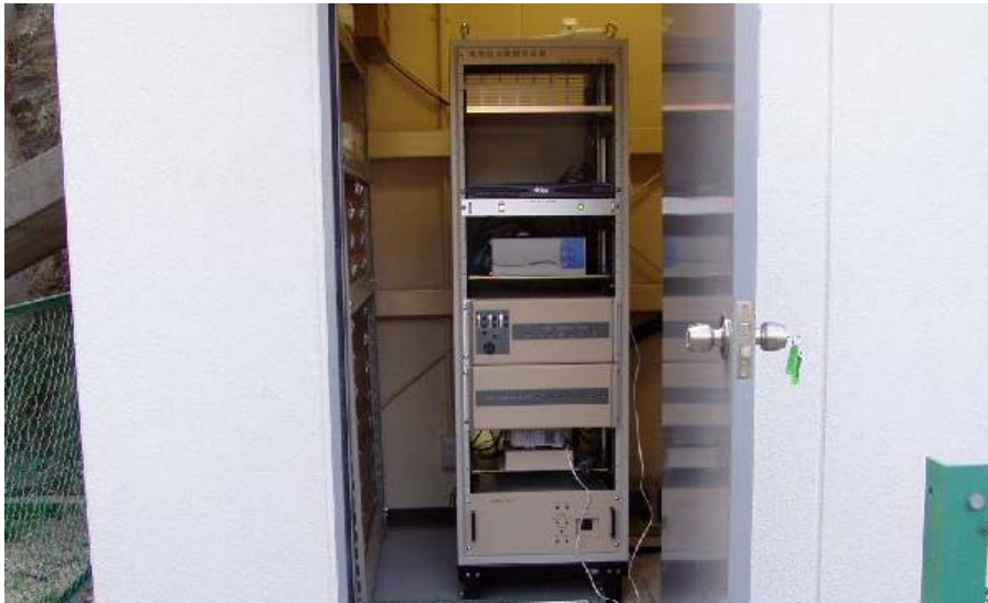
図 2 0 地上装置機器収納ラック
