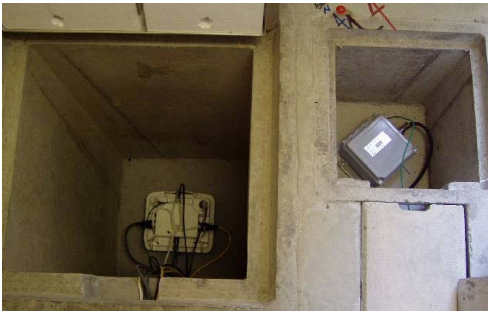
図19 観測施設内地下ピット
