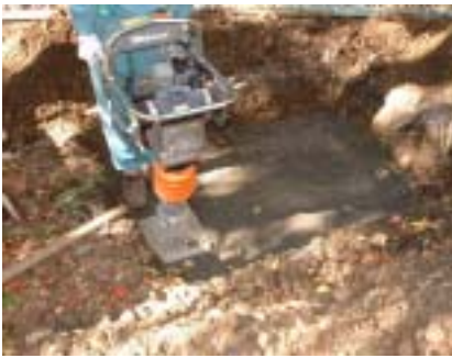
掘削した地盤面の突き固め作業
