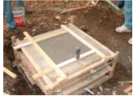
地震計台のコンクリート打ち状況
