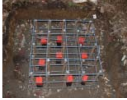
地震計台施工の配筋と杭（9本）
