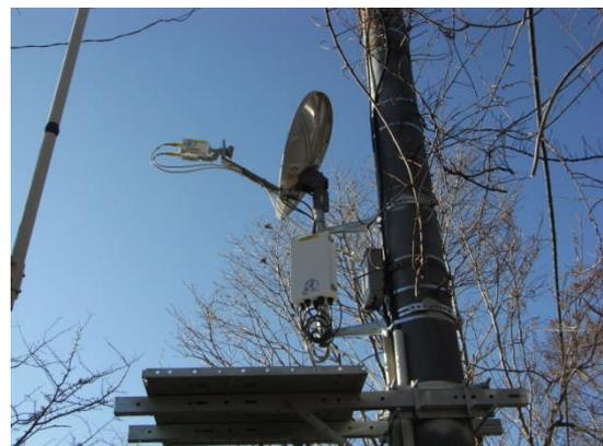
図5. 設置完了後の足場及び衛星装置
