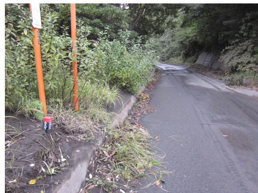
写真4 標柱設置
