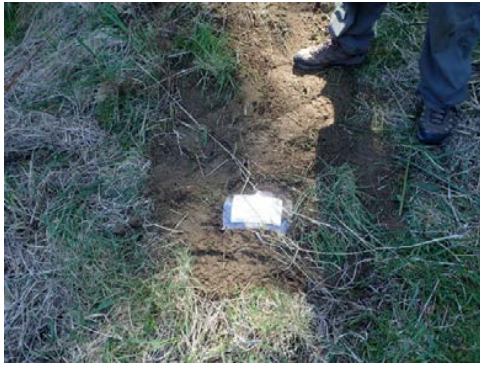
図3. GSX 設置写真（埋設後）GSX を埋め戻し、看板を設置する。
