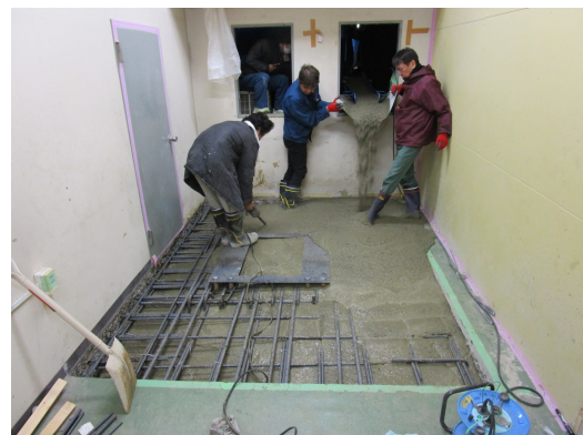
写真 1：生コンの流し込み
