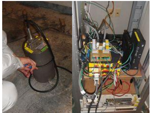
清澄観測点の観測機器 (左: 広帯域地震計(GURALP製、CMG-3T) 右: 収録装置(白山工業株式会社製、LFシリーズと電源装置・モデム))
