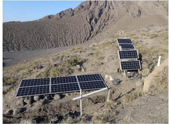
図 4. 強靱化後の引ノ平観測点ソーラーパネル配置図. 手前にある横長の筒が既設の無線 LAN アンテナ. 右側にある八木アンテナが新設の 400MHz 帯域無線アンテナ.
