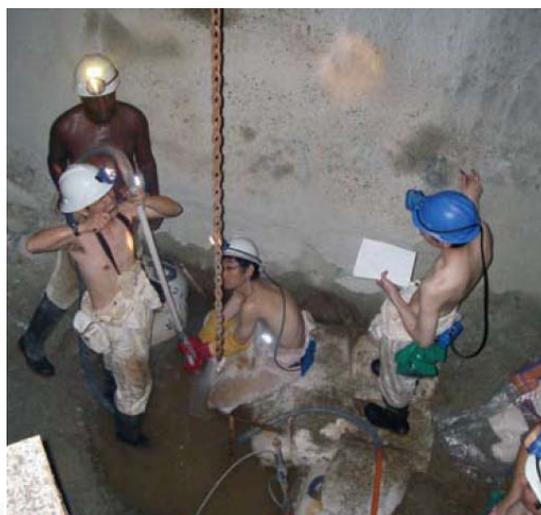
図 4 : 加速度計設置作業シーン
