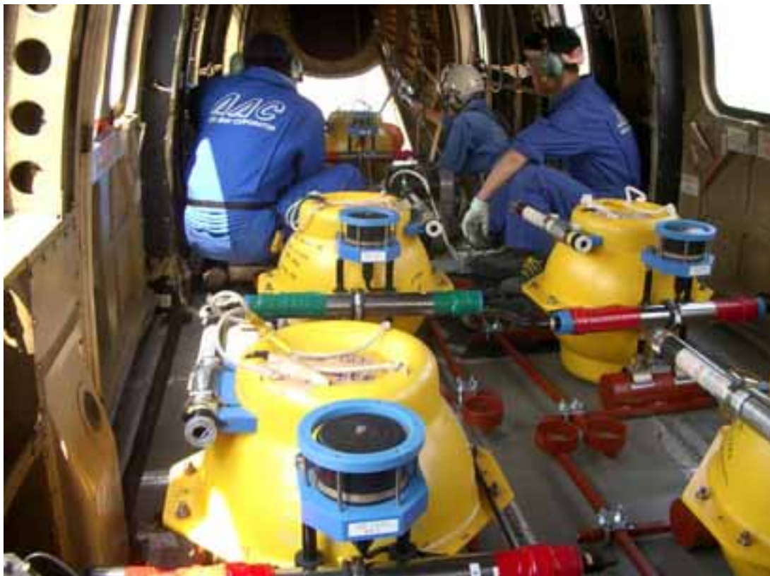
図 6 紀伊半島南東沖の地震余震観測における大型ヘリコプターによる自己浮上式海底地震計 5 台の設置作業
