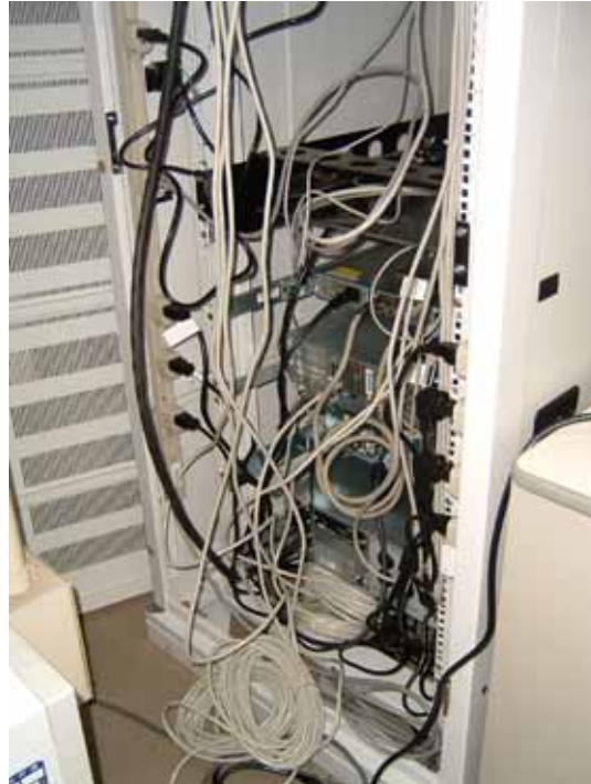
図2 大容量海底地震データ保存用ファールサーバー用計算機を搭載したラック裏面 高速スイッチング用 HUB、サーバ用モニター、データバックアップ用テープ・レコーダ、NAS 用コントローラー、NAS 用 Disk Array、そして無停電源装置(UPS)等が格納されている。 さらに地震の震源パラメータを求める震源計算処理ソフト、地震活動の時空間変化を視覚 化するためのアプリケーション・ソフト、ZMAP 法、およびをこの ZMAP 法をアクセスするた めのアプリケーション・ソフト、MATLAB ( 図 3 ) 等をこの地震波形処理用計算機システムに インストールした。また処理結果の図化されたものは新規に購入したカラープリンター LP9000C ( 図 4 ) にて出力される。
