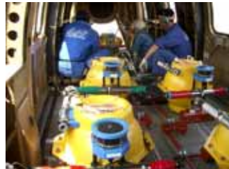
ヘリコプターによる自己浮上式海底地震計 5 台の設置作業
