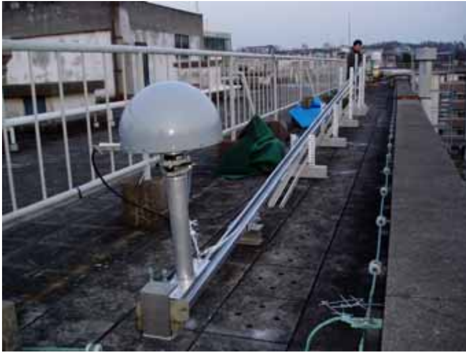
写真 1 移動局の名古屋大学屋上に設置したスライダと GPS アンテナ
