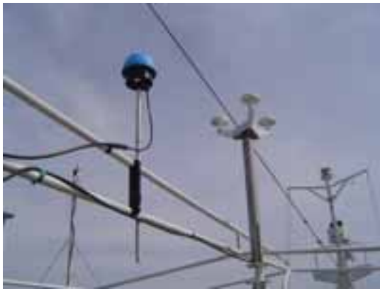
ブリッジ上のアンテナ 右側：サテライトコンパスアンテナ 左側：スターファイア DGPS 用
