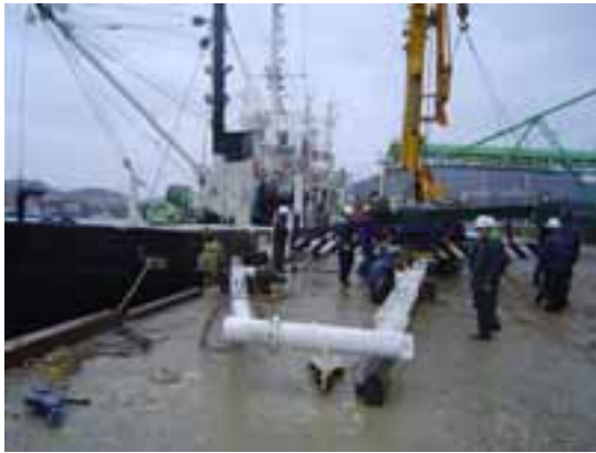
若潮丸艀装作業
