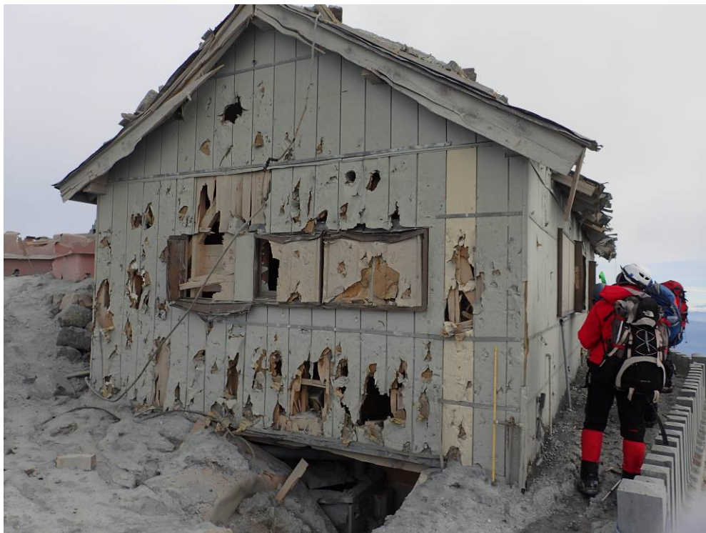
写真4 山頂（剣ヶ峰）の御嶽神社奥社建物の火口側（南西側）壁面. 山頂部の建物では火口側壁の損傷が著しい.
