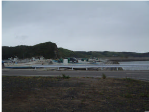
図 198-1 浸水した斜路
