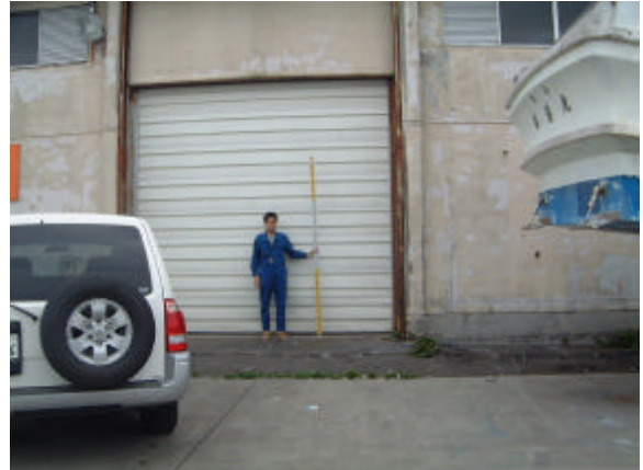
図202-2 シャッターの足下まで浸水
