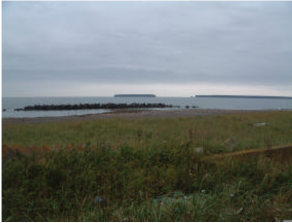
図 201-1 越波した消波ブロック
