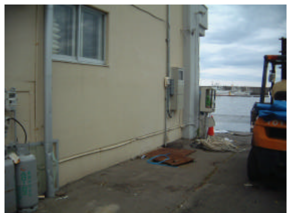
図 85-2 外壁の浸水線
