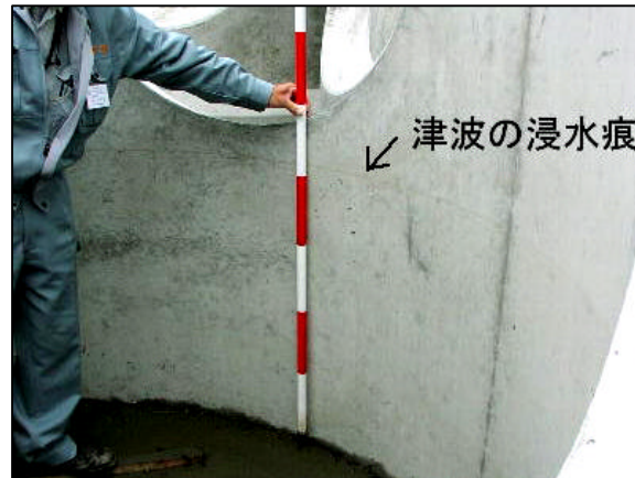
図 129-2 円筒漁礁に付着する浸水痕
