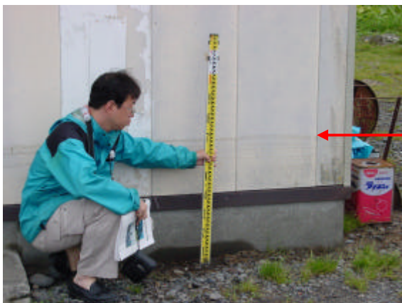
図 50-1 水塊が長時間滞留していたので、壁の色が変化している。（地点番号 50）
