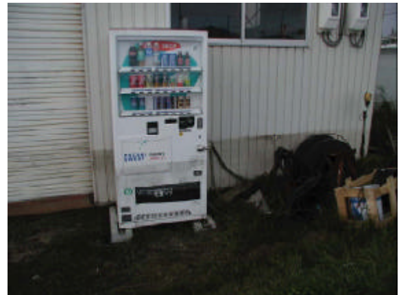
図 146-2 構造物に残された油脂類の跡
