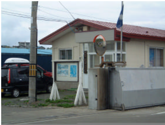
図 202-3 浸水したゲート
