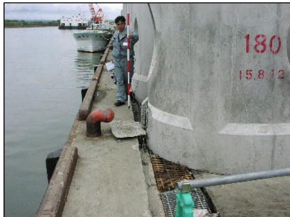
図 129-1 津波痕跡が残る大津港岸壁の円筒漁礁
