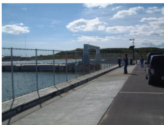
図 141-3 浮きドックの海側のフェンス
