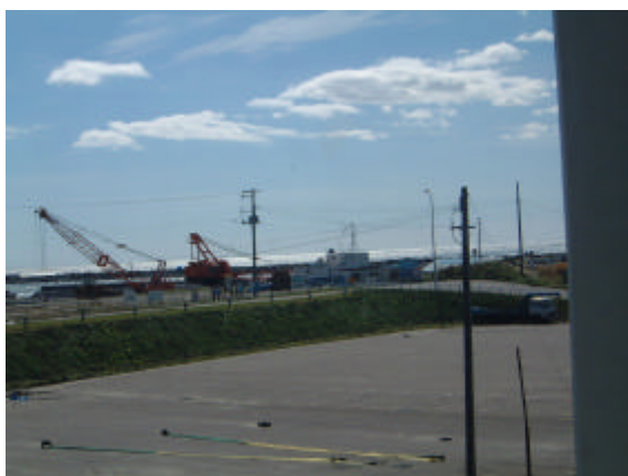
図 141-1 港外へ流された工事用の船
