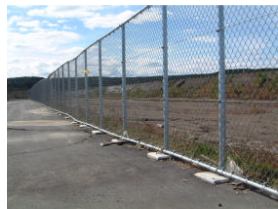
図 142-1 浮きドックの陸側のフェンス
