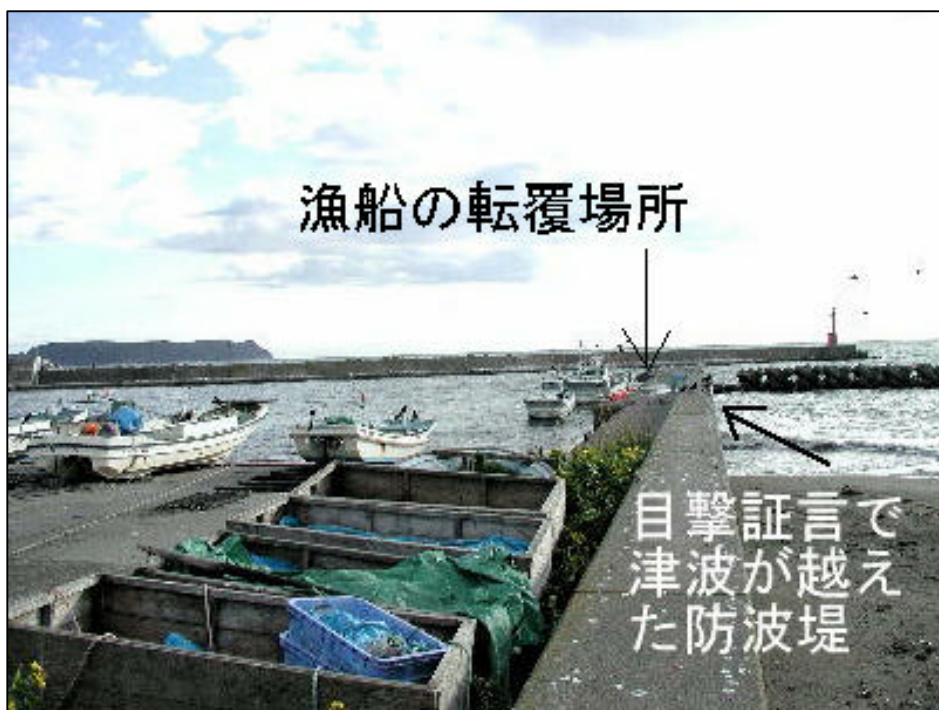
図 180-1 津波高を測定した床潭の西防波堤
