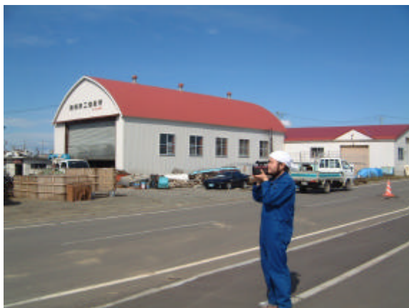
図 119-1 外壁に浸水線が残っていた造船所
