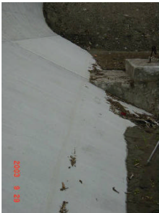
図 193-1 海岸堤防の海側側面に残された泥の線
