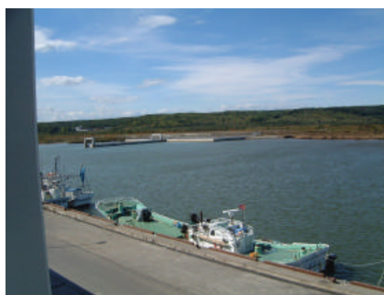
図 141-2 漁協から見た浮きドック
