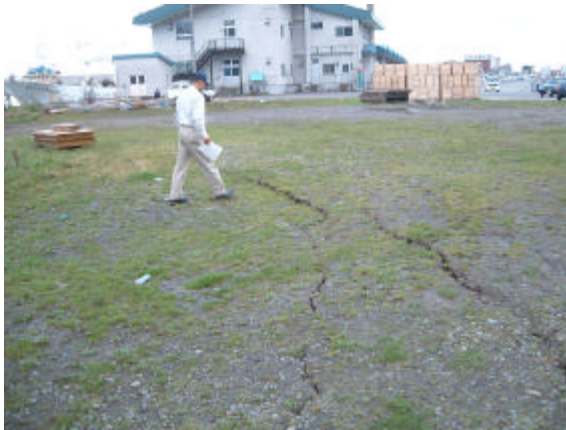
図 49-1 十勝港の岸壁付近倉庫
