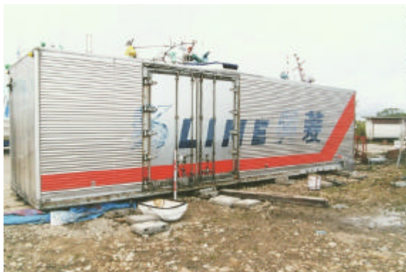
図 104-1 コンテナ外壁の津波痕跡。
