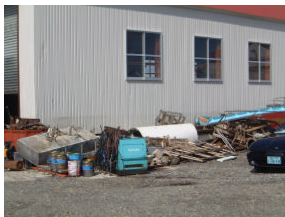
図 119-2 外壁の浸水線
