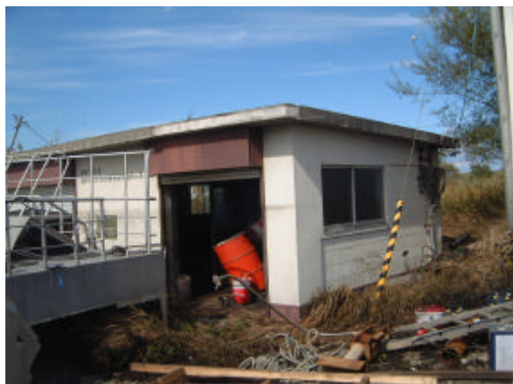
図 120-1 外壁に浸水線が残っていた漁船上架施設
