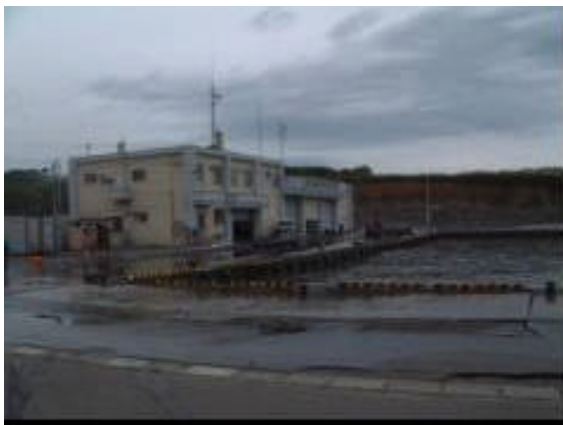
図 85-1 外壁に浸水線が残っていた漁協
