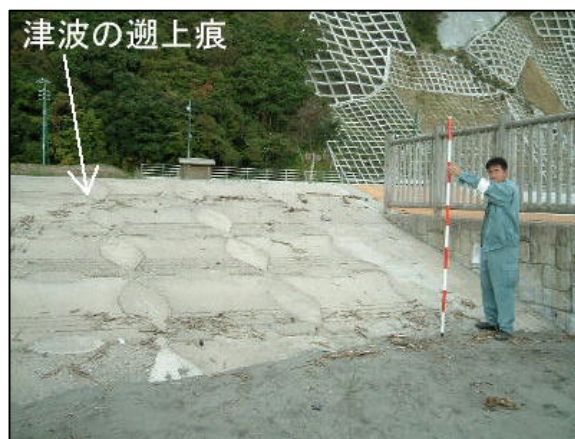
図 16-2 護岸堤のゴミ
