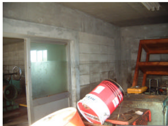
図 120-2 漁船上架施設の内壁の浸水線
