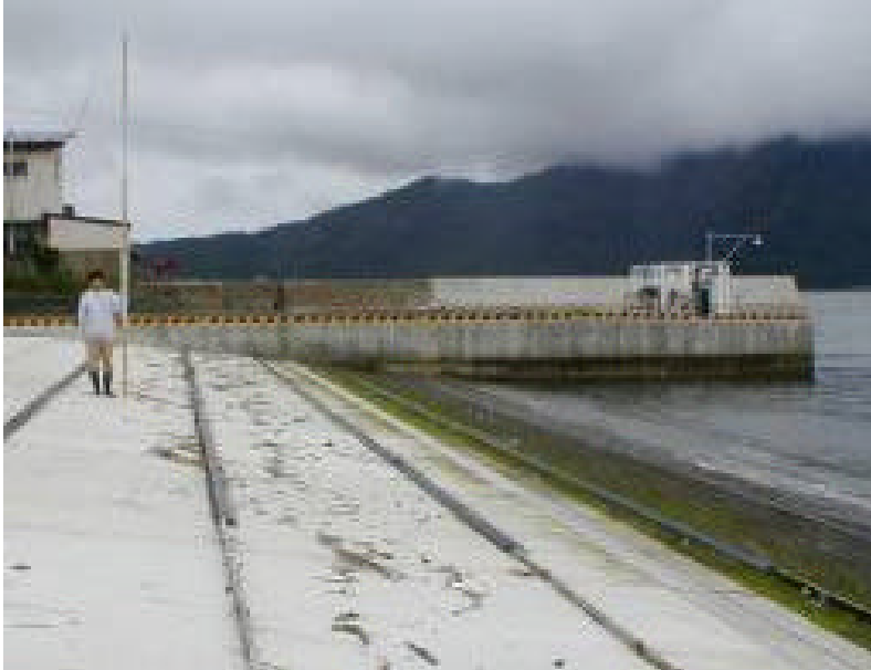
図 207-1 港内斜路上に打ち上げられた浮遊物
