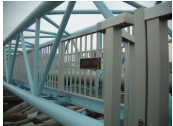
図 170-2 釧路町水管橋
