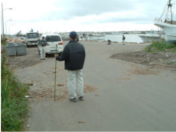
図 151-1 厚内漁港内道路上の津波痕跡
