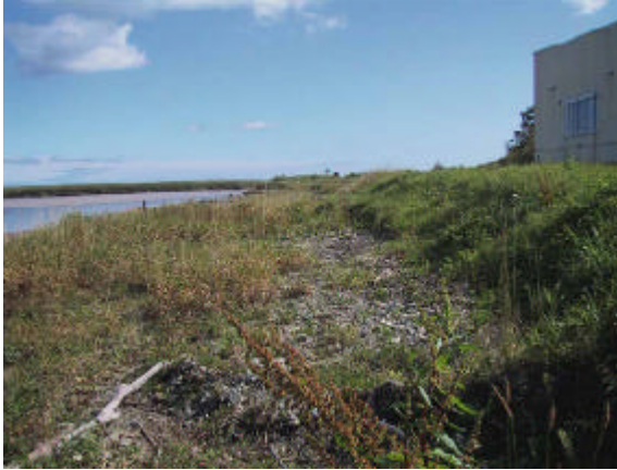
図 218-1 津波が遡上した痕跡
