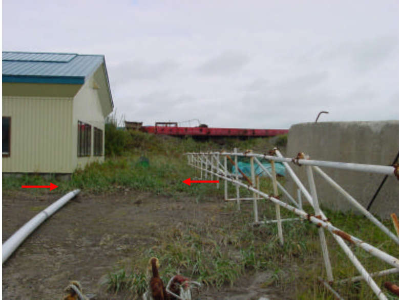
図 121-1 低草に残された津波の痕跡．海域から陸側へ向かって倒れている．(地点番号 121)
