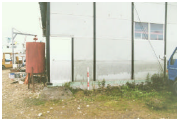
図 108-1 プレハブ外壁の津波痕跡。
