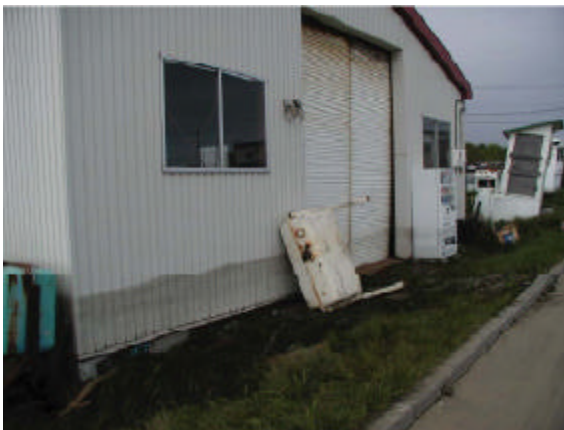
図 146-1 津波による水位上昇の痕跡
