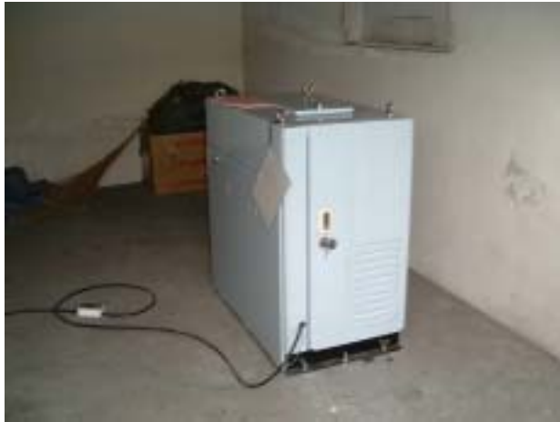
図5. 絶対重力計のために、気象庁により設置された発動発電機(500kg)。泥流で荒れた無人島での設置のために、道路啓開用のパワーショベル1台、クレーン1台、大型トラック1台、連絡用4輪駆動車1台が投入された。
