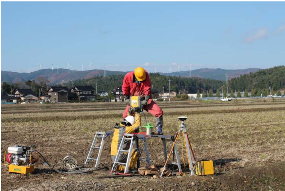
打撃式簡易ボーリング装置による調査（石川県珠洲市宝立町地内）
