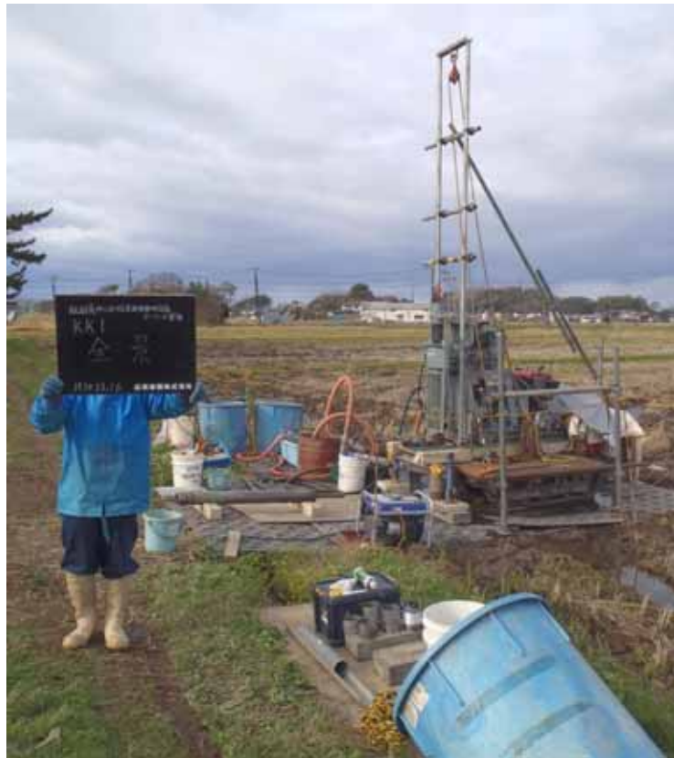
KK1 孔でのボーリング調査
