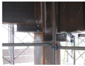
梁の根元の耐震補強
