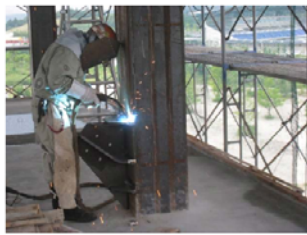
制振ダンパー取り付け部の現場溶接
