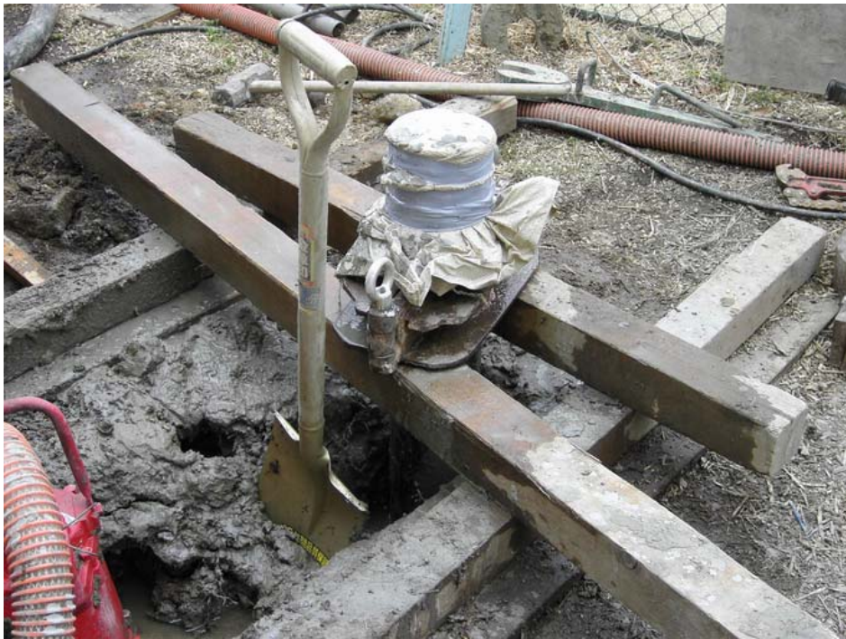
写真 1. 掘削風景。 上; 掘削中、下; 掘削完了
