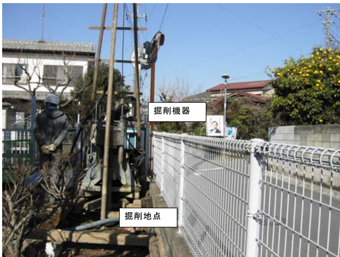
写真1 掘削工事（二本松小学校）
