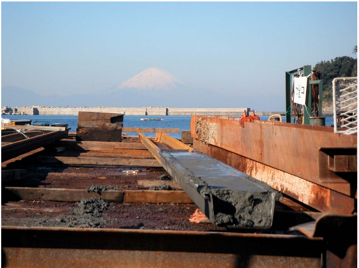
図 9. (上) ジオスライサー掘削作業風景 (下) 採取された試料
