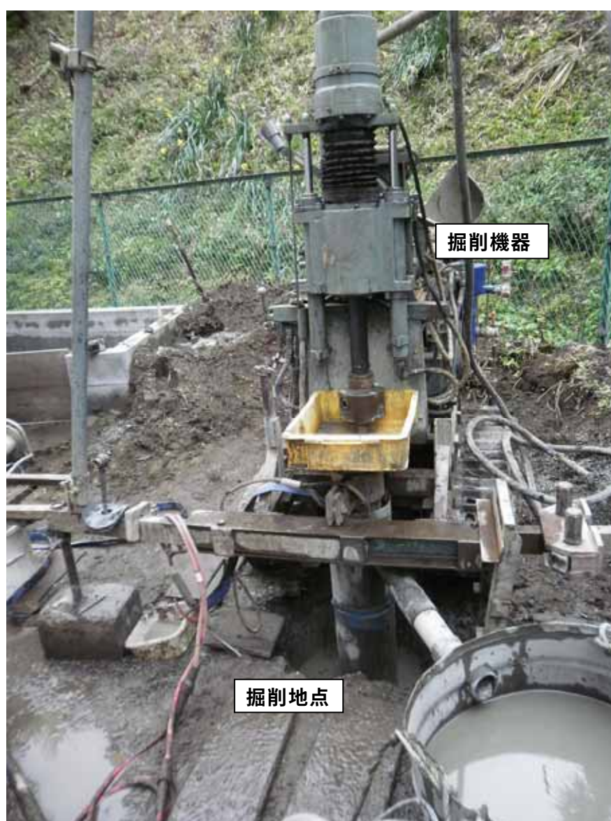
写真 1 掘削工事 (横浜市北方小学校)
