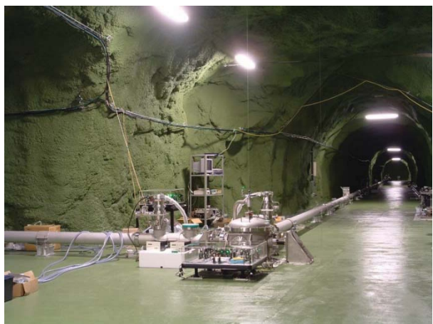
神岡鉱山（地下1000m）に設置されたレーザー伸縮計
