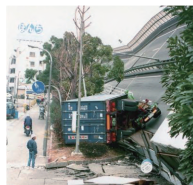
兵庫県南部地震で倒壊した阪神高速3号神戸線（写真提供：神戸市）
