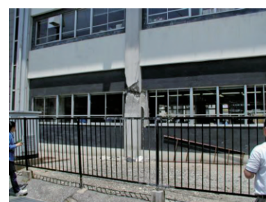
2003年宮城県沖地震で被災した役所建物（鉄筋コンクリート柱のせん断破壊）
