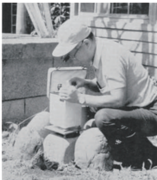
ラコステ重力計による測定作業 （1974年頃）
