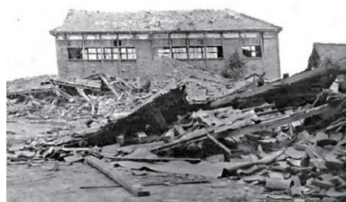
福井地震による小学校の被害（1948年）
