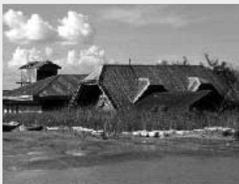
↑ピナツポ火山噴火の土石流で埋没した家屋
