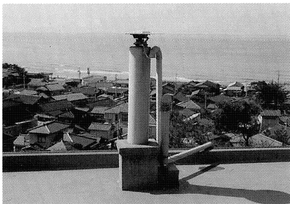
図 3. 弥彦地殻変動観測所庁舎屋上のアンテナ固定柱
