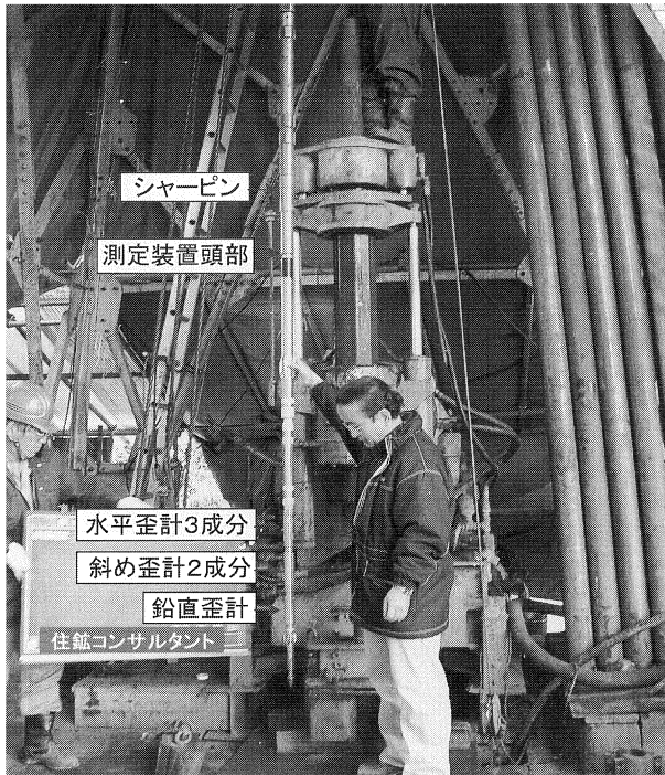
図 5. インテリジェント回収型歪計（3号機）埋設
