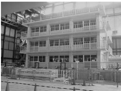
図 6. 耐震補強を施していない試験体
