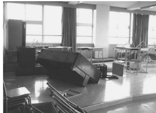
図 18. 2004年新潟県中越地震での小千谷市立東中学校4階の音楽室の状況
