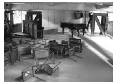
図 13. 加振後の3階音楽教室の状況
