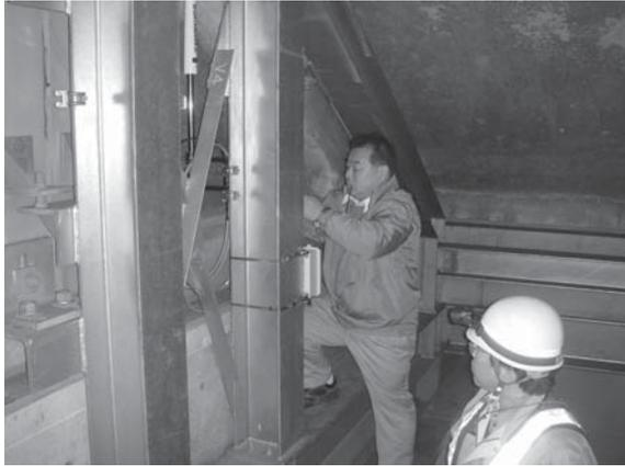
図 36. 風の塔非常出口付近のデータ送信装置の取付け状況
