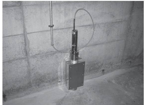
図 28. 地震計を取付けアルミ金具で覆い保護した状況（海ほたる）
