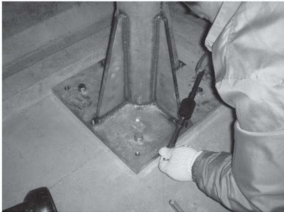
図 32. 風の塔に設置した地震計台座のタップ作業 (ネジ切)
