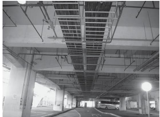
図 14. 1 階駐車場天井の配管配線の布設状況（海ほたる）
