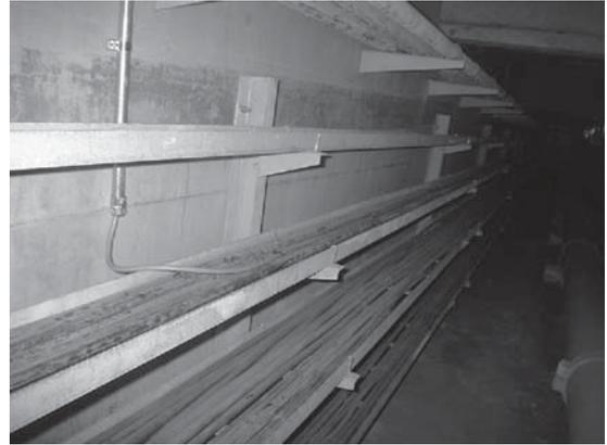
図 12. 地震計設置付近の既存配線布設の利用（海ほたる）
