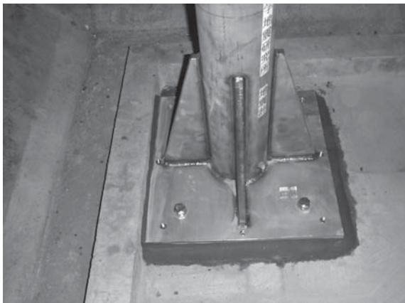
図 33. 地震計設置台座をボルトで固定した状況 (風の塔)
