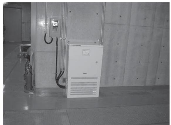
図 30. 収録装置筐体の取付け状況. 左上：電力メータ（海ほたる）
