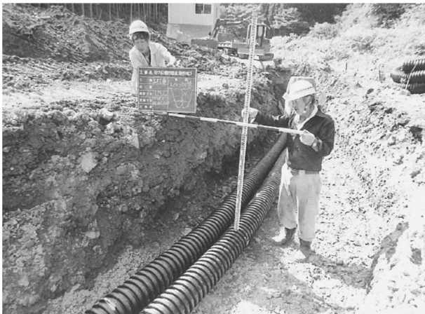
図6. 布団カゴを敷いた急斜面と一部の緩斜面は光ケーブルをエフレックス管で防護し埋設した。
