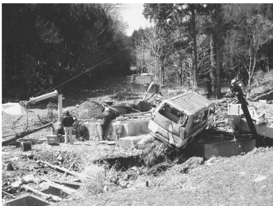
図 2. 平成 23 年 4 月 12 日における釜石局舎付近の調査，局舎は完全に流失し，通信アンテナ用のマストもへし折れている（左）。また，海岸付近は津波で大きく土壌がさらわれ，光ケーブルの一部が露出していた（右）。
