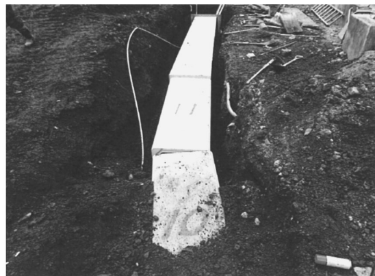
図7. 釜石陸上局舎付近は、新システム増設時に重機によって複数回掘り出されることが想定されるため、エフレックス管をコンクリート製のU字溝で防護した。
