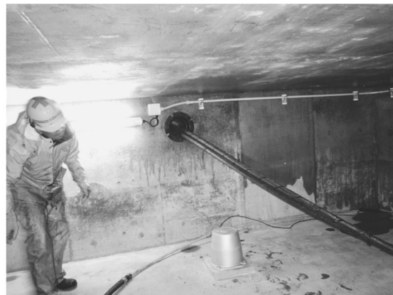
図 12. 新局舎地下ピットへの光ケーブル・ビーチアースケーブルの引き込み風景
