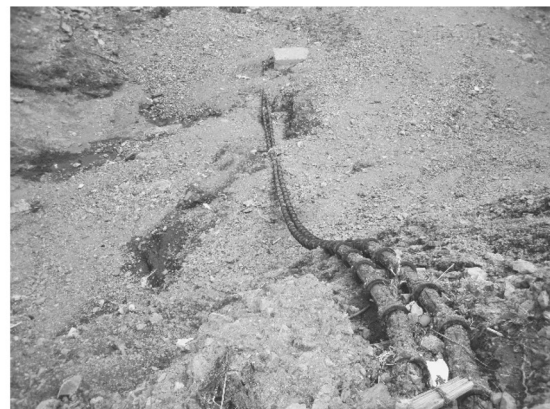
図 2. 平成 23 年 4 月 12 日における釜石局舎付近の調査，局舎は完全に流失し，通信アンテナ用のマストもへし折れている（左）。また，海岸付近は津波で大きく土壌がさらわれ，光ケーブルの一部が露出していた（右）。
