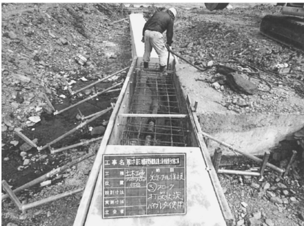
図 5. 海岸に近い部分は光ケーブルに防護管をかぶせてコンクリートで埋めた
