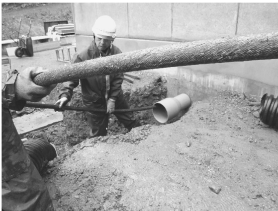
図 12. 新局舎地下ピットへの光ケーブル・ビーチアースケーブルの引き込み風景
