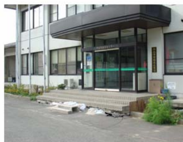
門前町防災センターの地盤沈下の例
