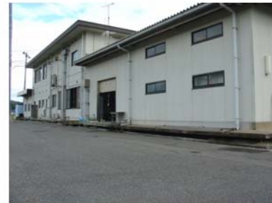
門前町防災センターの地盤沈下の例
