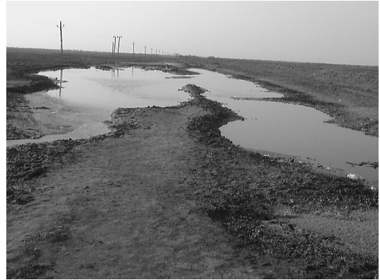
図 9 地下水の噴出跡2. この地点は地震のあと1.2メートルほど水を吹き上げていたそうである。
