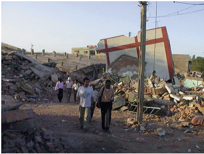
図 4 (本文p. 3) ほとんどの建物が倒壊したBachauの街．ここはもっとも被害が激しい街の一つであった．
