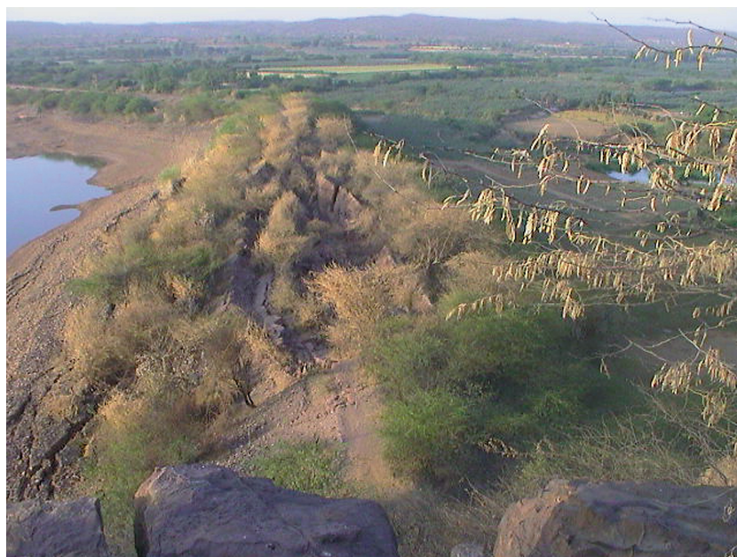
図 7 (本文p. 3) 地割れを近くの丘から俯瞰する．長さ約200メートルにわたって大規模な地割れが発生している．
