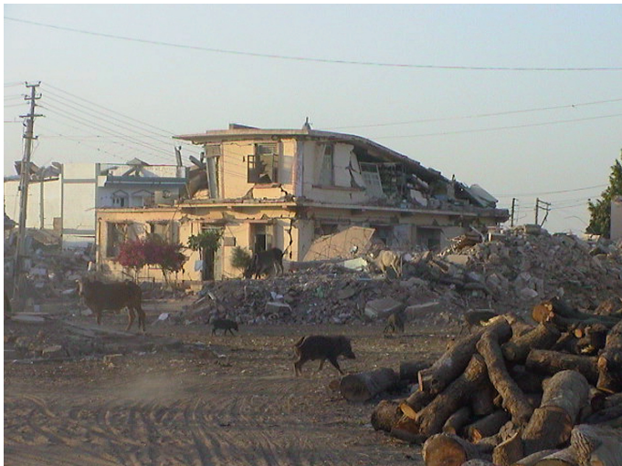
図 5 (本文p. 3) 建物の典型的な崩壊の仕方．多くの建物は煉瓦造りで中には鉄筋すら入っていないため，上部から崩壊している建物が見受けられた．
