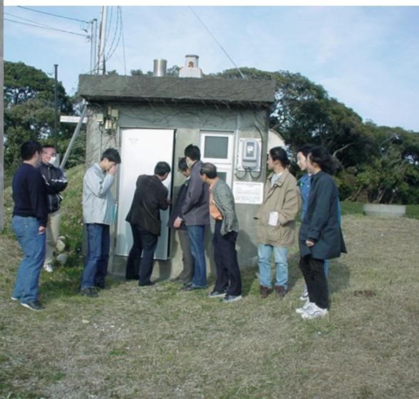
写真2 (本文p. 6) 静岡県相良にある地殻変動施設点検。
