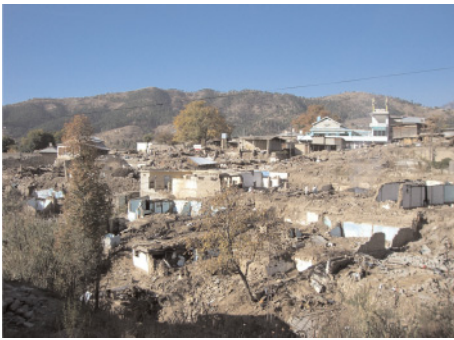
③ Battal 震央から北西約 30km
