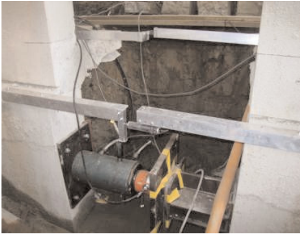
図 6：実際の建物での杭の静的水平載荷実験
