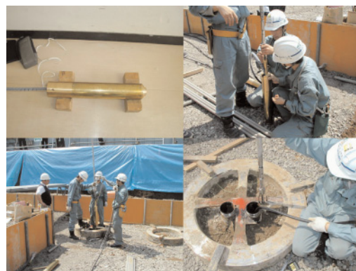
図2：地震計の杭への埋設
