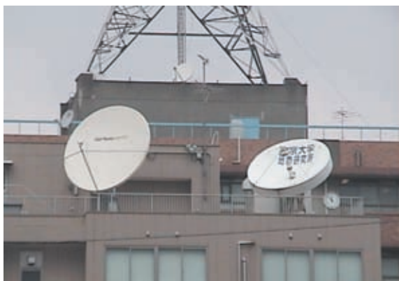
衛星テレメータシステム親局のパラボラアンテナ。 Satellite dishes at the ERI hub of the satellite seismic telemetry system.
