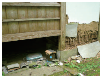
震源域に地震前から設置していたオフライン観測点。本震発生前にメンテナンスを行ってデータを取得できている（写真提供：九州大学地震火山観測研究センター）
