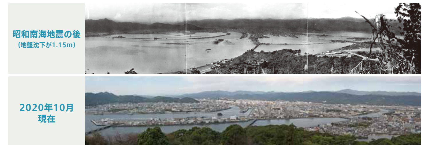
高知市の五台山から見た昭和南海地震発生翌日の高知市街と現在の市街。地震後には地盤の沈下によって市内の広い地域が水没しているのが分かります。提供:(上)高知市(下)高知県
